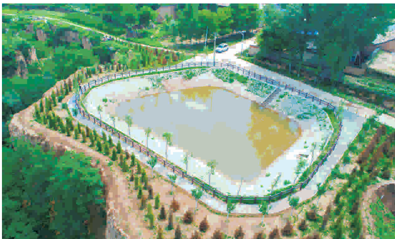
图21 咸阳市旬邑县塬面保护工程
