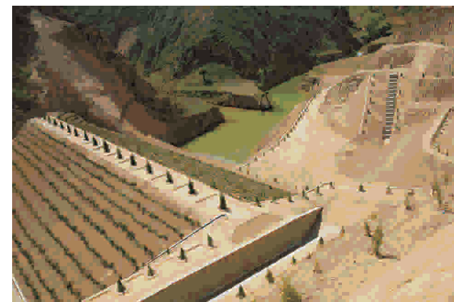
图14 榆林市子洲县正沟淤地坝除险加固工程
