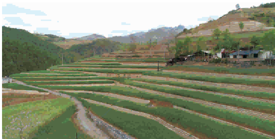
图17 汉中市略阳县白水江项目区坡耕地综合治理工程
